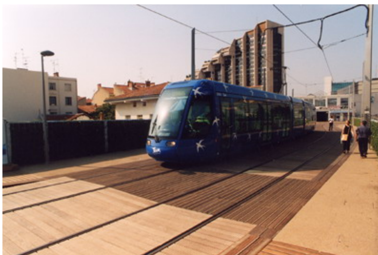
Habillage-bois des voies du tramway - Montpellier, France
