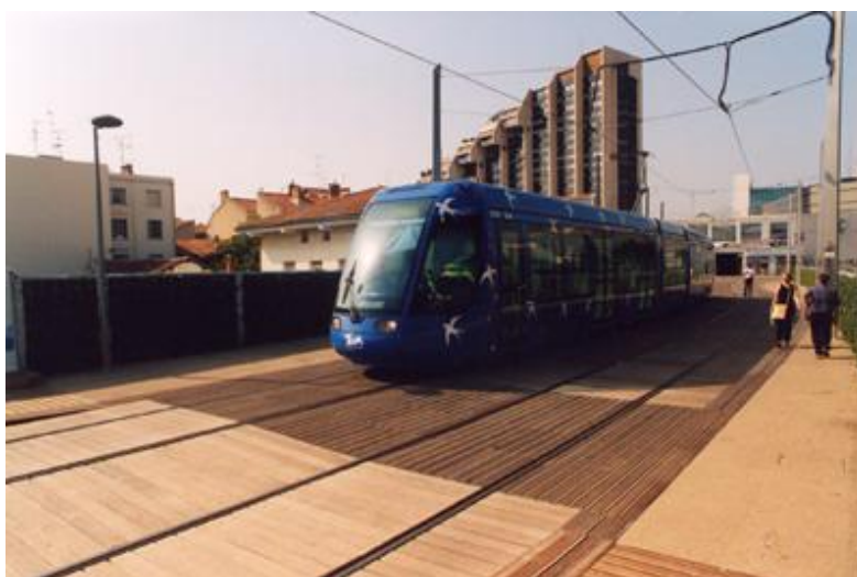
Habillage-bois des voies du tramway - Montpellier, France (© Michel Vernay)
